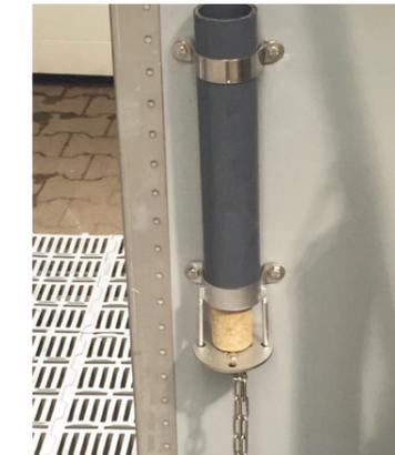
**Rohrhalter an Trennwand mit Bodenplatte**
